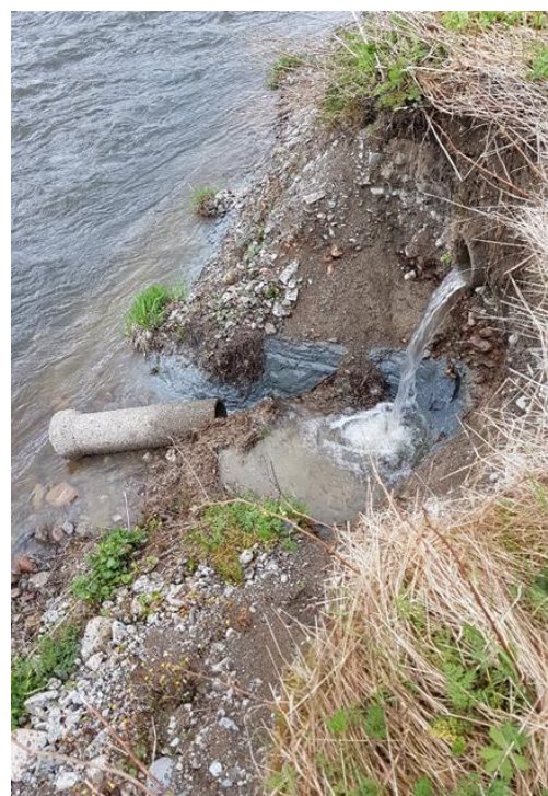
Erosjonssikring av utløp og elvekant
