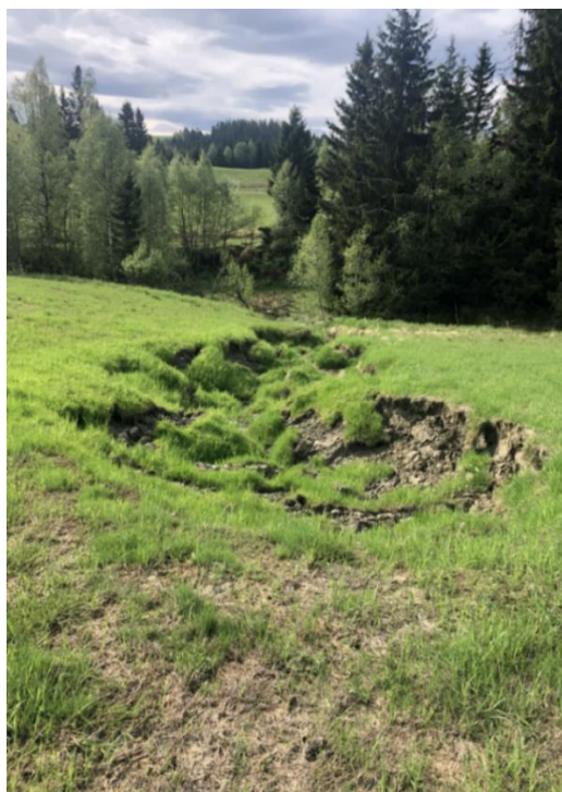
Utsifting av kollapset betongrørgate
