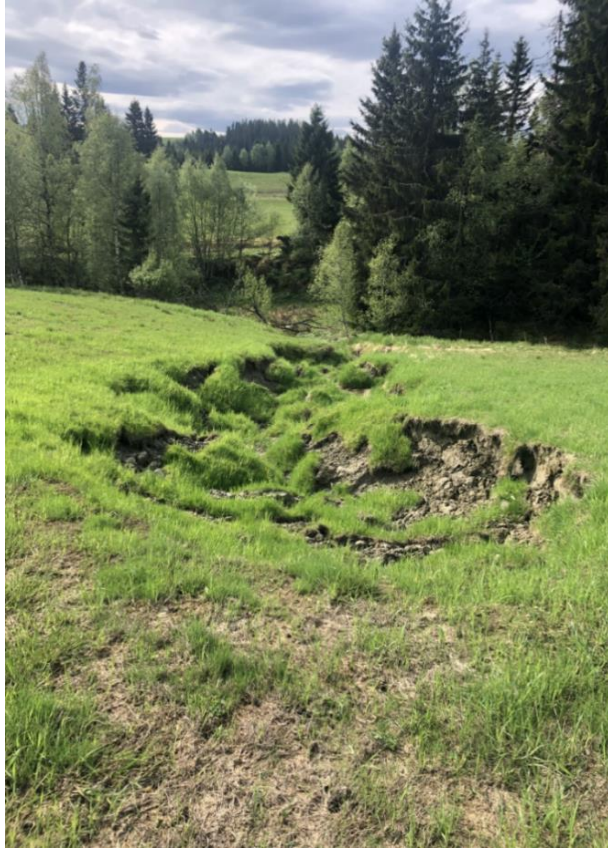
Utskifting av kollapset betongrørgate
