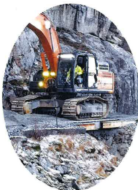
Arbeid med Setransveien
