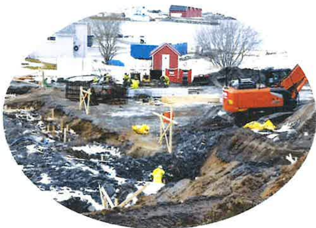
Fra byggeplass, Flerbrukshus, ved skolen
